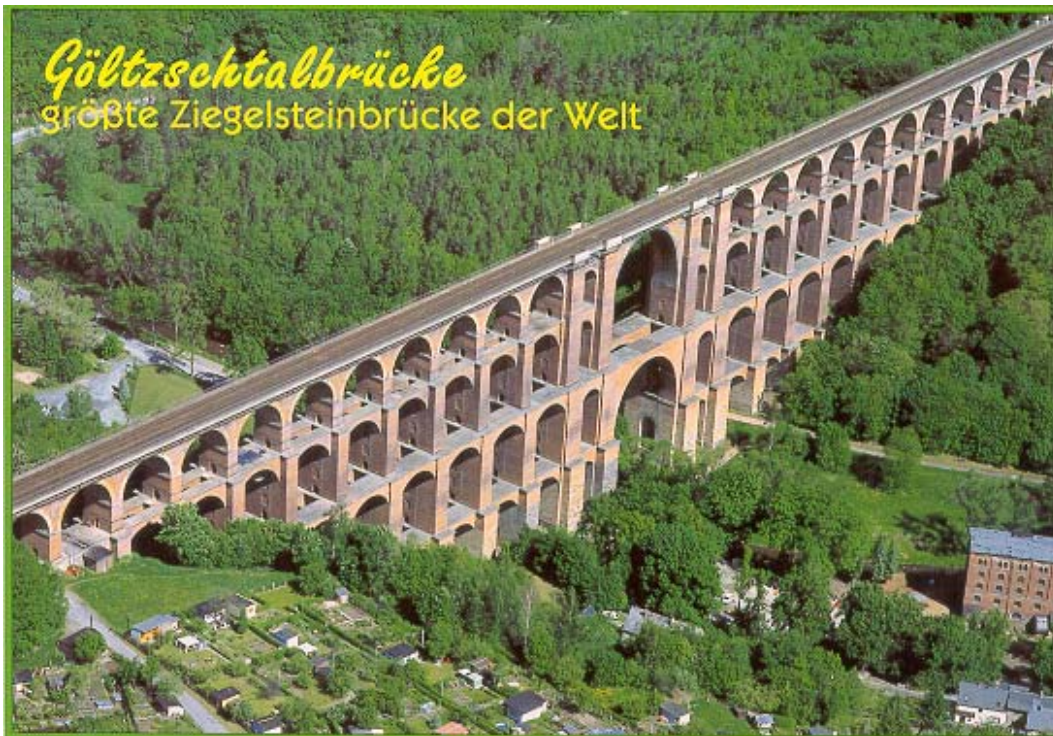
Fig. 1: Göltzschtalbrücke (Foto [F1])
